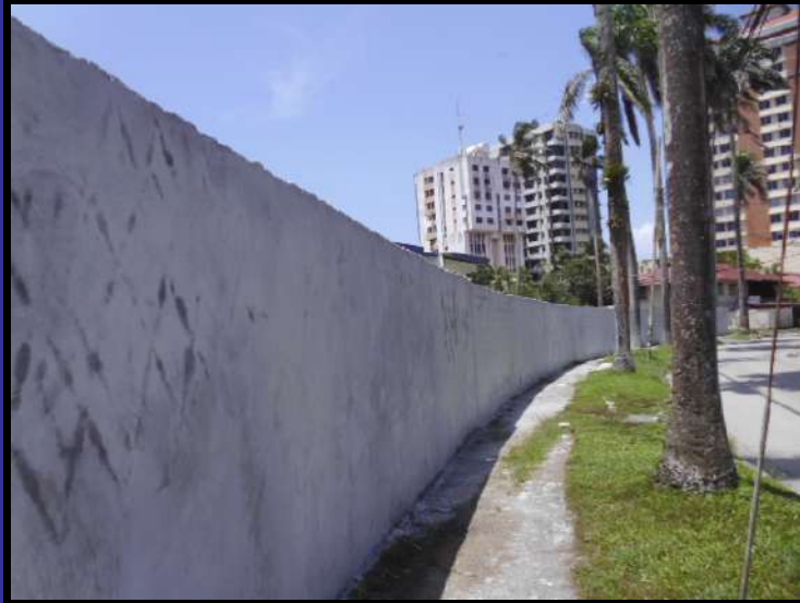
Adecuación de la Cerca Perimetral, sistema eléctrico y contra incendio
