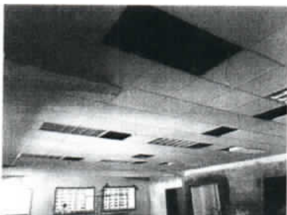
Imagen 3: Colocación de cielo raso en cocina - comedor
