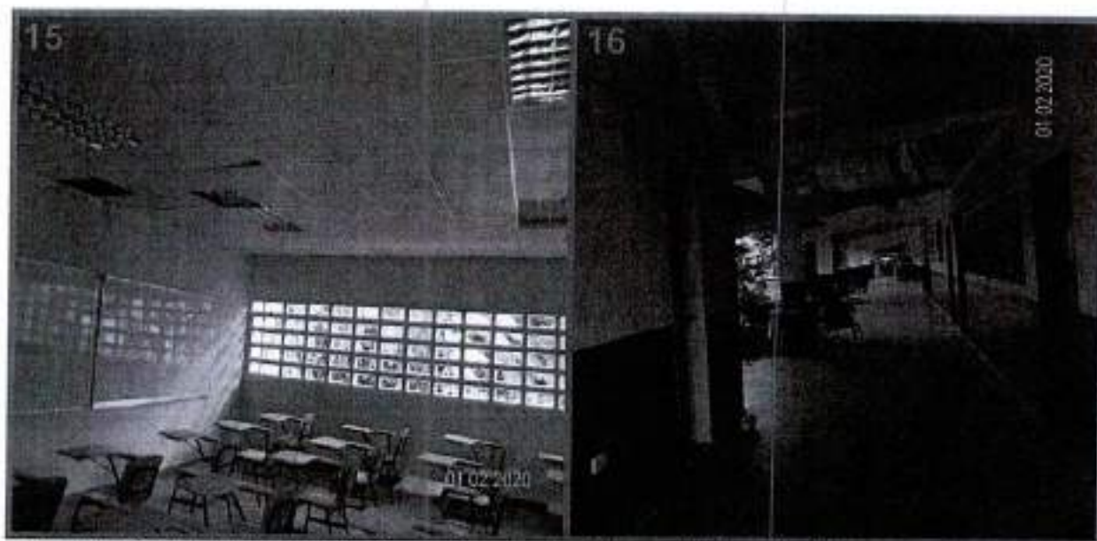
Fotos 15,16. Se observa el estado de abandono de los trabajos eléctricos de cielo raso en las aulas o salones de clases (fotos tomadas desde ornamentales de ventanas) y en pasillos. (no se observa personal de Obra).
