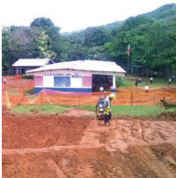
C.E.B.G. Cerro Caña, Movimiento de Tierra Proyecto Distrito de Muná. 6/6/2016
