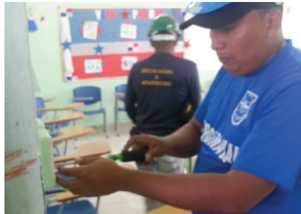
Mantenimiento en Centro Educativo en la Región Escolar de Panamá Centro.
