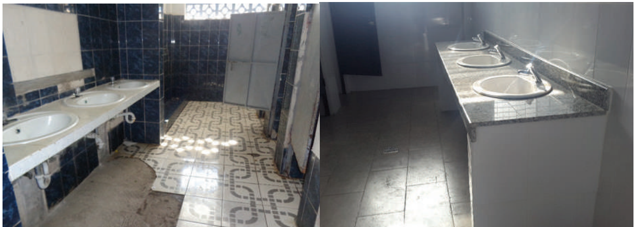
Baños del Colegio Félix Olivares (Antes y después)
