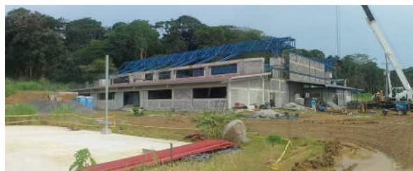
Avances de la construcción de la Escuela El Hijo del Carpintero, Veracruz.
