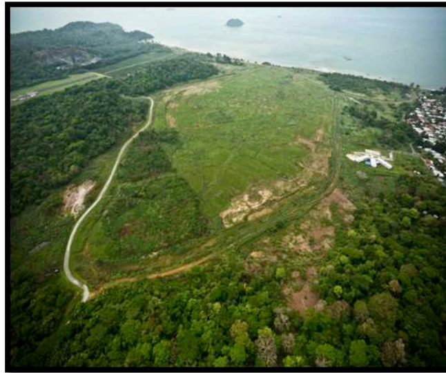
Figura 3. Vista aérea del área actual de construcción del centro educativo donde se aprecia la inexistencia de calle de acceso e infraestructura.
