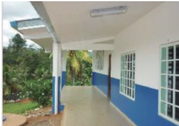
Centro Educativo Quebrada Pinzón, Bocas del Toro, corregimiento del Cauchero, Proyecto en ejecución.
