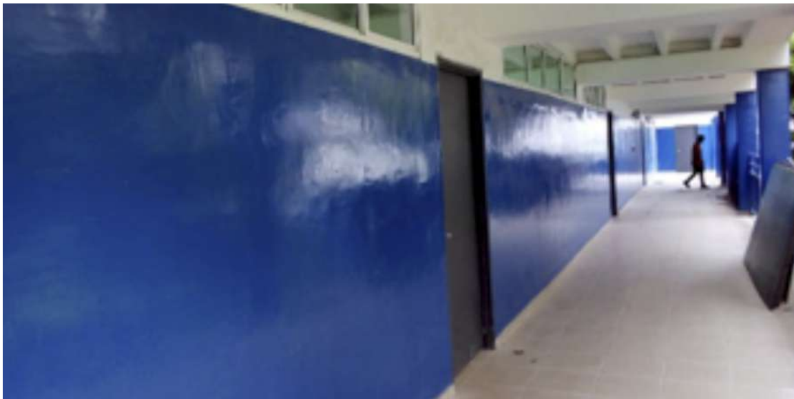
Instituto Rufo Garay, Colón, corregimiento Barrio Norte, Proyecto en Ejecución
