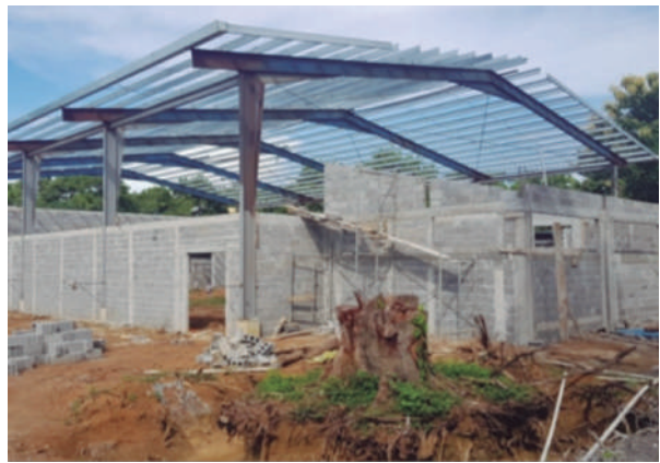
Escuela Punta chame, Panamá, corregimiento de Punta Chame, Proyecto en Ejecución.
