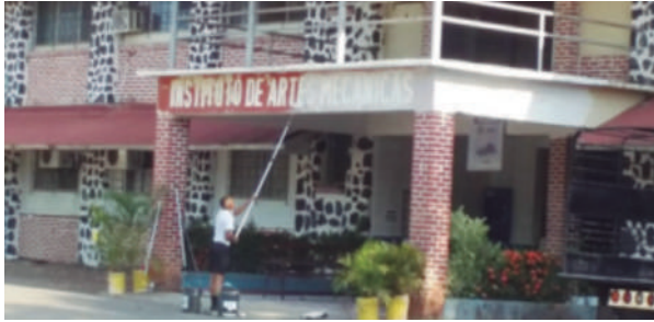
Rehabilitación de Instituto de Artes Mecánica, Herrera.
