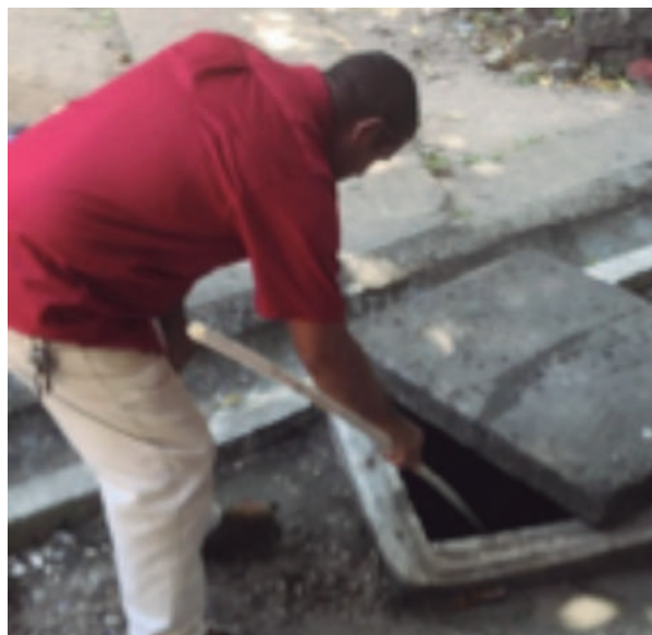
Reparación de sistema sanitario, Esc. Árabe de Egipto, Panamá Norte
