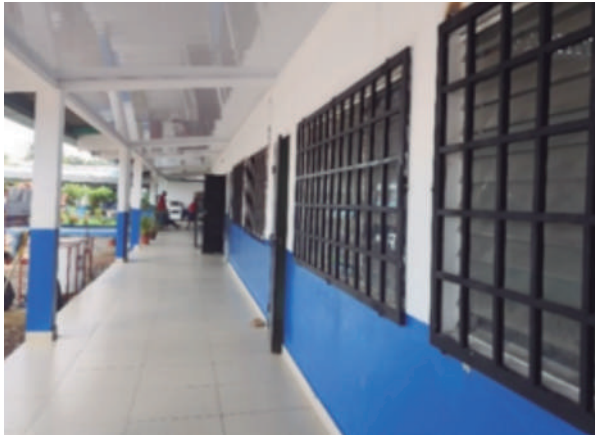
Colegio Secundario Las Lajas, Chiriquí, corregimiento de las Lajas. Proyecto Terminado.
