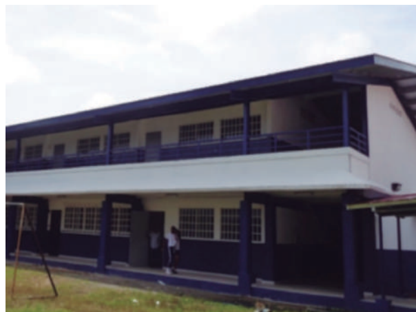
Escuela Simón Urbina, Colón, corregimiento del Cristóbal. Proyecto Terminado.
